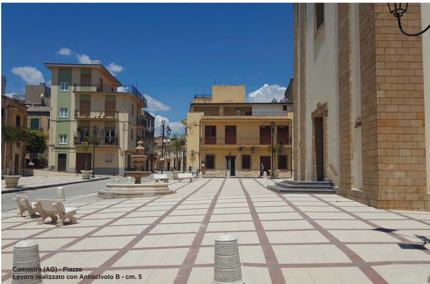
Mascalci - Fraz. Nunziata (CT) Lavoro eseguito con Antiscivolo E - cm. 3
