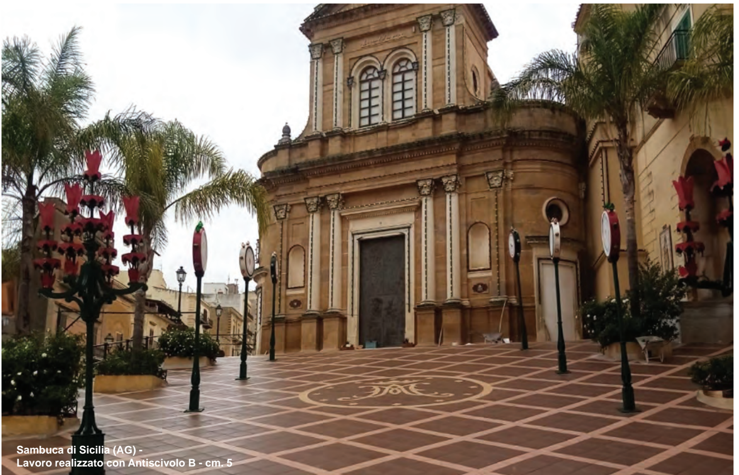
Giarre (CT) - Marciapiedi Lavoro realizzato con Antiscivolo B - cm. 3
