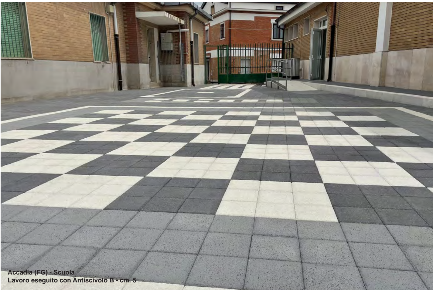
Porticello - Santa Flavia (PA) - Lungomare Lavoro eseguito con Antiscivolo B - cm. 3
