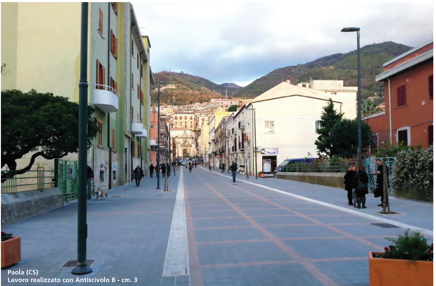
Scalea (CS) - Sede stradale Lavoro realizzato con Antiscivolo E - cm. 5
